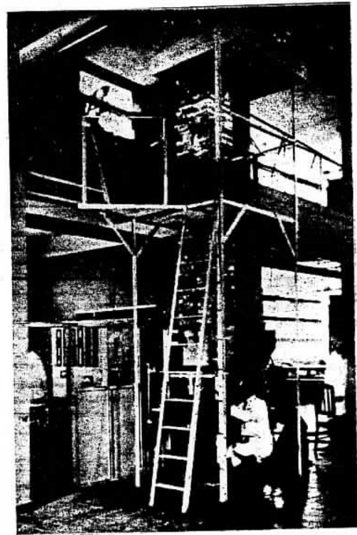
Fig. 14.— Reactor fluo-sólido de Dorr-Oliver
