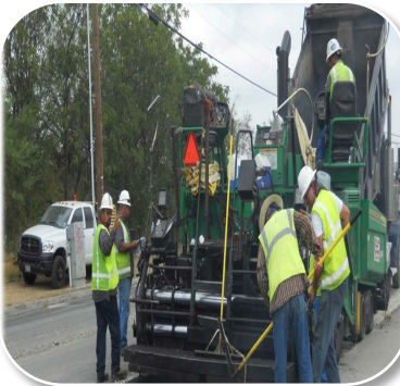
Hot Mix Asphalt
